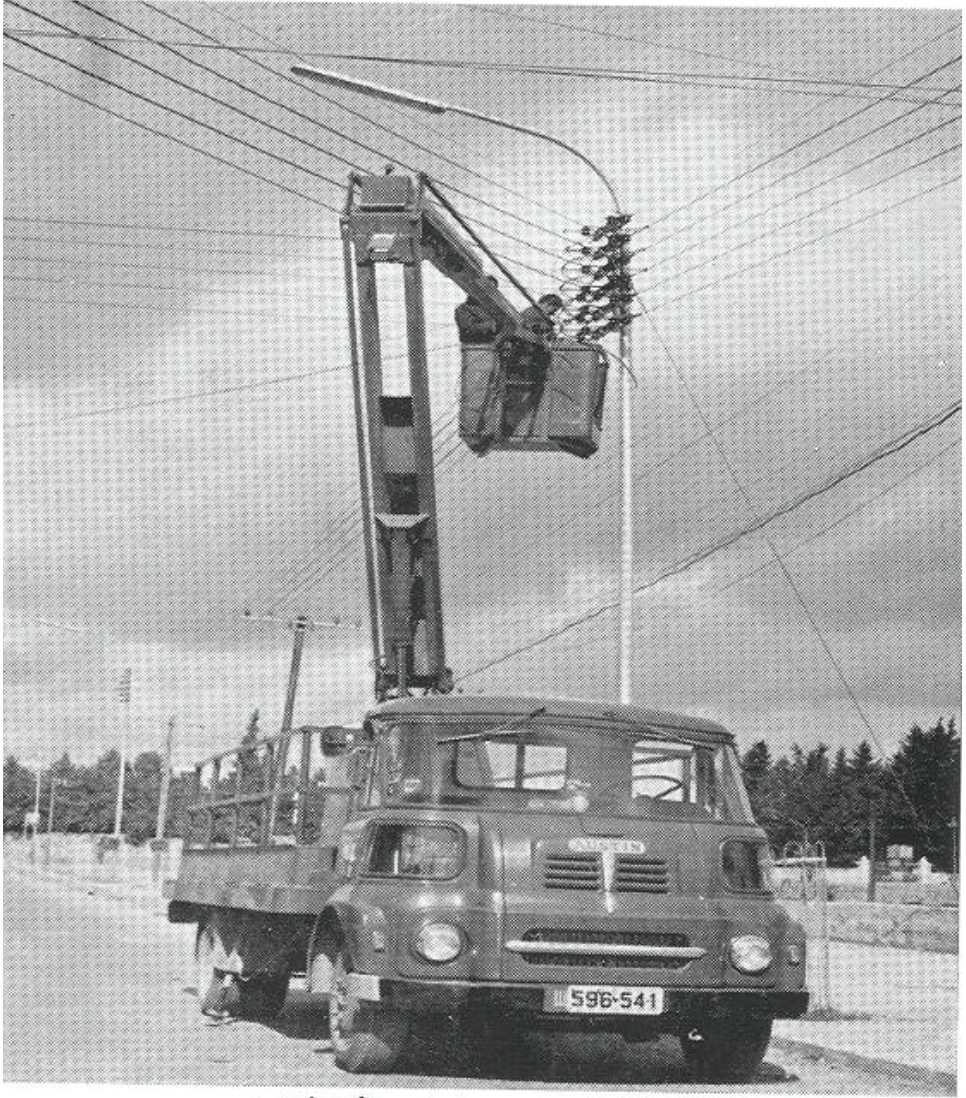
( عمال الكهرباء يقومون باصلاح شبكة الانارة )
