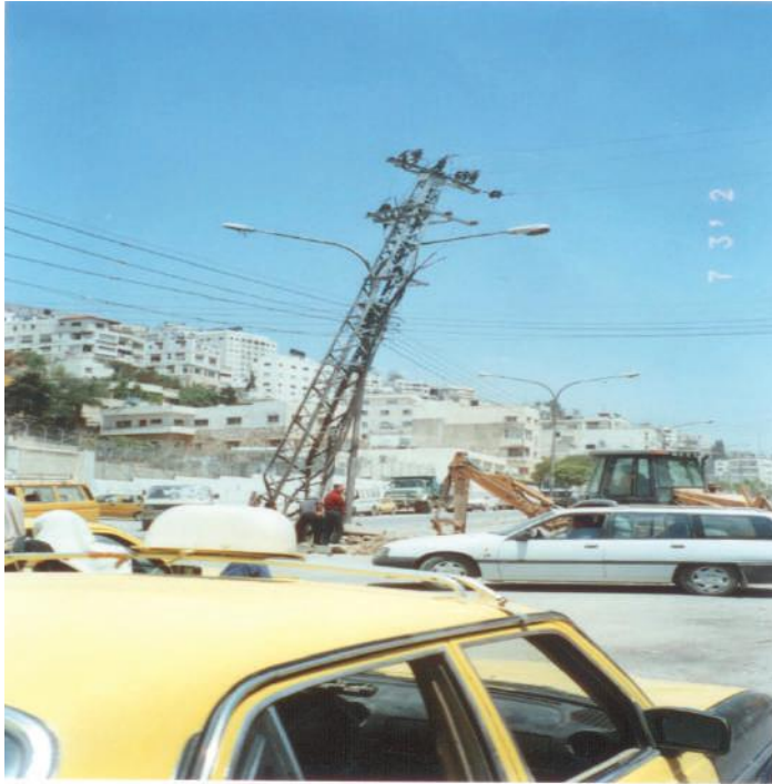
صورة لبعض الأضرار التي لحقت بشبكات الكهرباء نتيجة لاجتياحات قوات الاحتلال الإسرائيلي لمدينة نابلس ٢٠٠٢م
